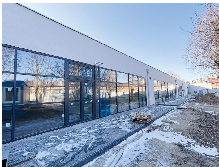
Budowa nowego budynku przedszkola publicznego we Wrześni
