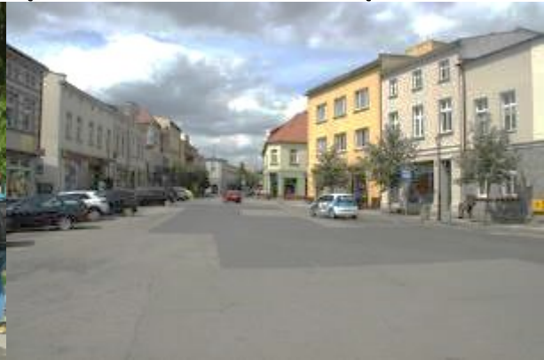
Stan nawierzchni pasa technicznego jezdni przy złączeniu ulic Sienkiewicza z Harcerską
