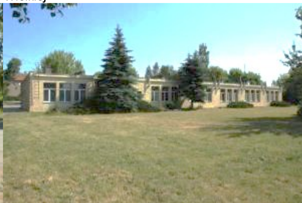
Budynek zamkniętej szkoły podstawowej w Chociczy Wielkiej
