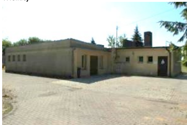
Budynek zamkniętej szkoły podstawowej w Chociczy Wielkiej
