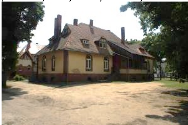
Stan techniczny zamieszkałych budynków pokoszarowych w rejonie ulicy Koszarowej
