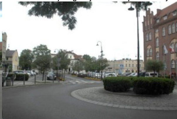
Stan infrastruktury drogowej wzdłuż ulicy Ratuszowej
