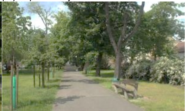
Stan nawierzchni ścieżki pieszej wzdłuż skweru ulicznego przy ulicy Harcerskiej
