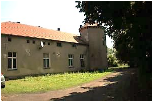
Widok na dwór w Gutowie Wielkim
