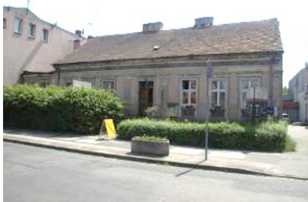
Przykład niszczącego budynku jednorodzinnego z pokryciem dachowym zawierającym azbest w rejonie ulicy Warszawskiej
