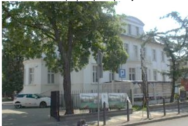
Okazała kamienica przy ulicy Fabrycznej
