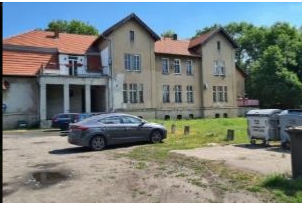
Widok na dwór w Gutowie Wielkim
