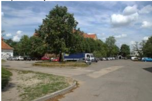
Stan nawierzchni powierzchni parkingowej w rejonie ulicy Koszarowej
