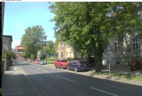
Stan techniczny pasa technicznego jezdni wzdłuż ulicy Staszica
