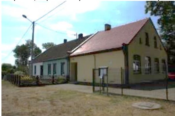
Wyremontowany budynek świetlicy wiejskiej w Strzyżewie, współdzielony z zasobem mieszkaniowym
