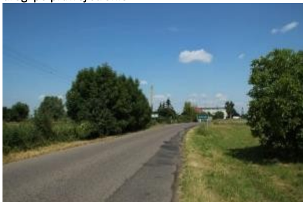
Wjazd do centrum Otocznej, splekana nawierzchnia drogi po prawej stronie
