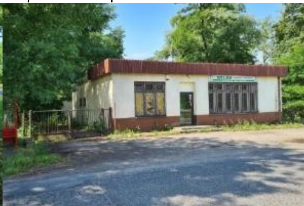
Budynek po zlikwidowanym sklepie spożywczym nieopodal Parku Napoleona
