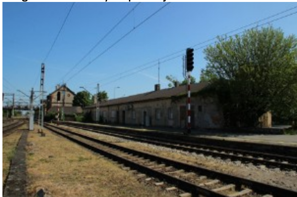
Zdegradowane budynki pokolejowe
