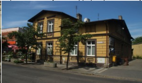
Atrakcyjna kamienica w rejonie ulicy Warszawskiej
