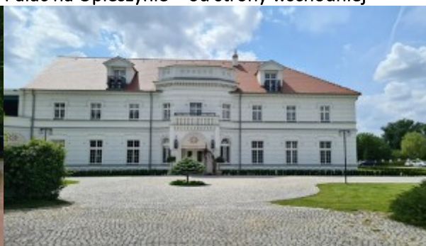
Pałac na Opieszynie – od strony wschodniej
