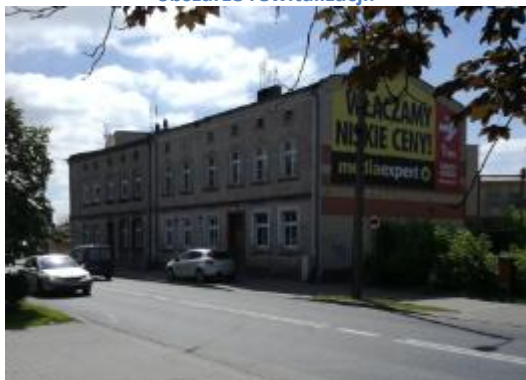
Zdjęcie 16 Zdegradowane budynki mieszkalne na obszarze rewitalizacji.
