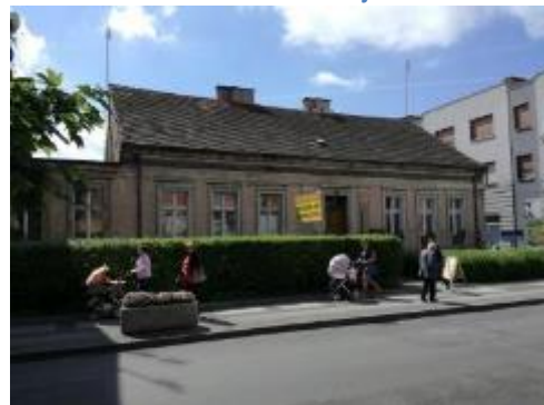
Zdjęcie 23 Zdegradowana zabytkowa kamienica w centrum Wrześni.
